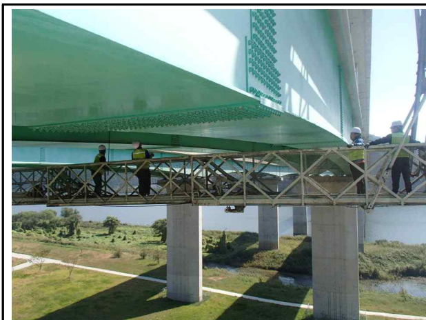
교량점검차를 이용한 조사
