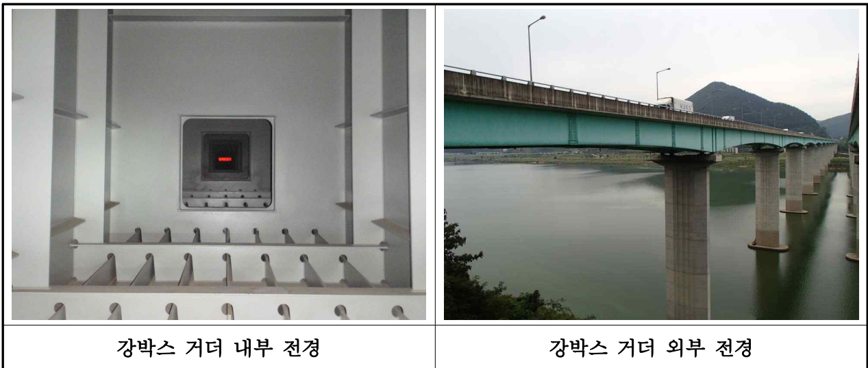
【사진 3.2.3】 강박스 거더 전경(대구)
