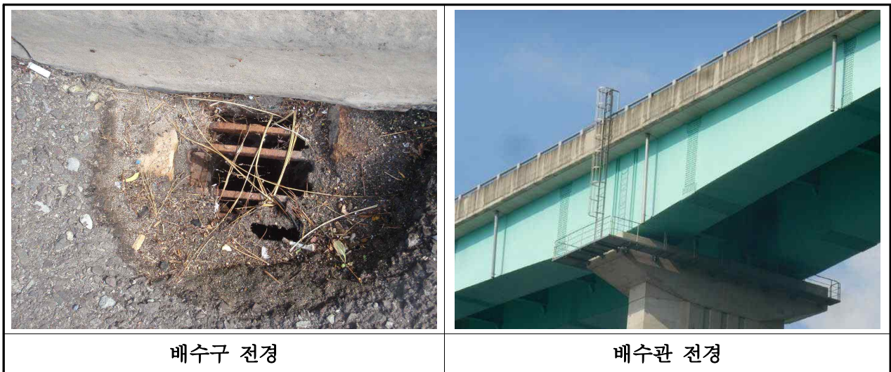
【사진 3.2.21】 배수구 및 배수관 전경(대구)
