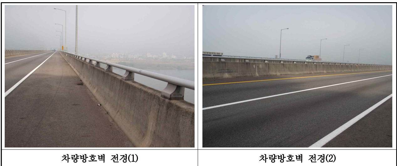
【사진 3.2.23】 방호벽 전경(대구)
