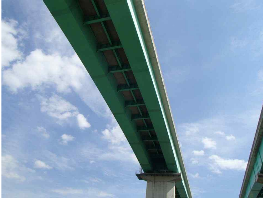
바닥판하면 및 강박스 외부 전경
