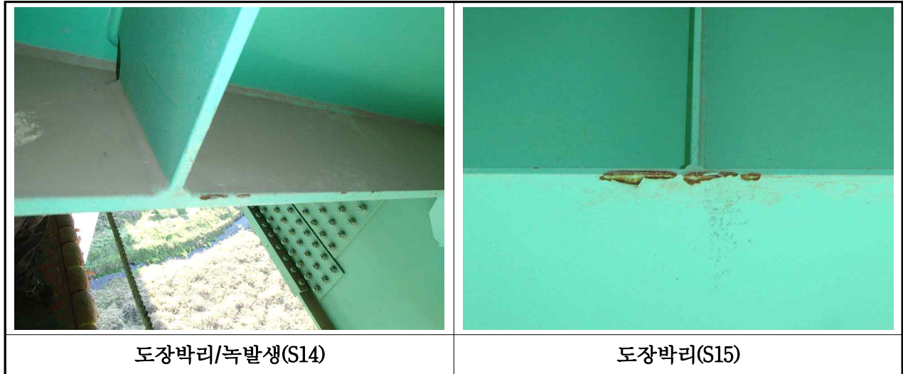
【사진 3.3.6】 가로보 및 세로보 전경(부산)
