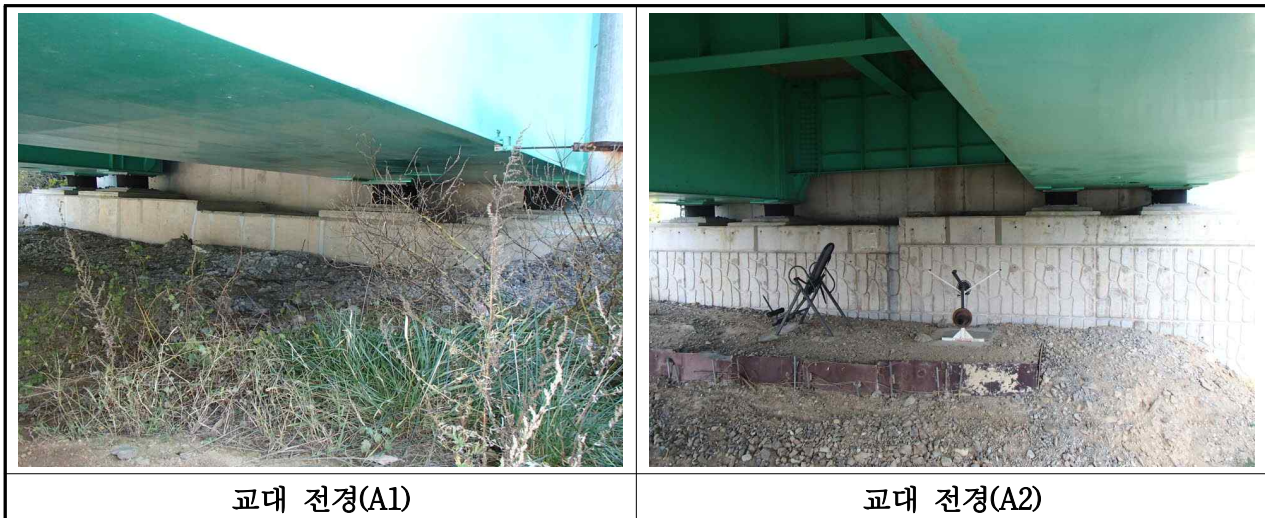
【사진 3.3.7】 교대 전경(부산)
