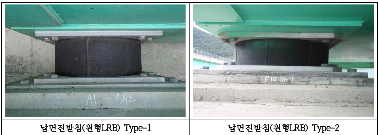
【사진 3.2.14】 교량받침 전경(대구)
