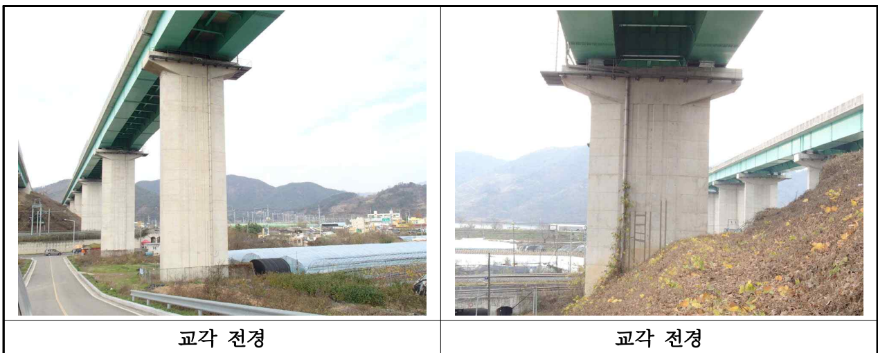
【사진 3.2.9】 교각 전경(대구)
