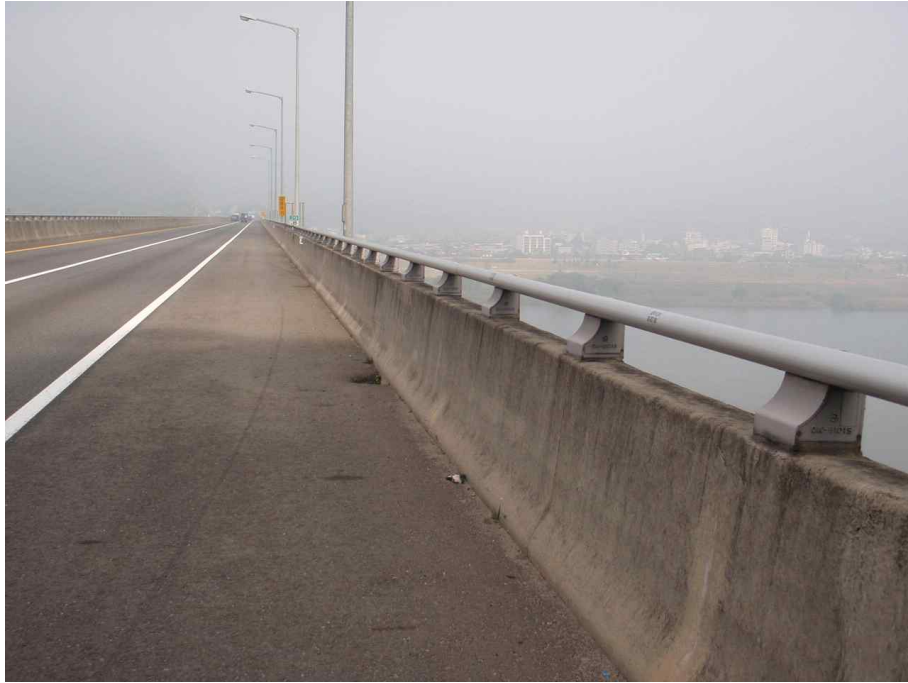
차량방호벽 전경 (1차로측)
