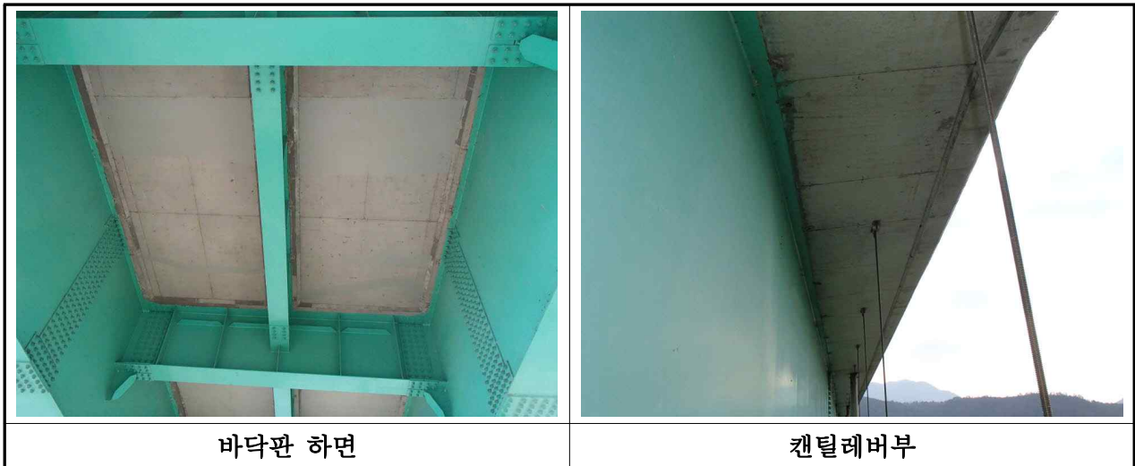
【사진 3.3.1】 바닥판 전경(부산)
