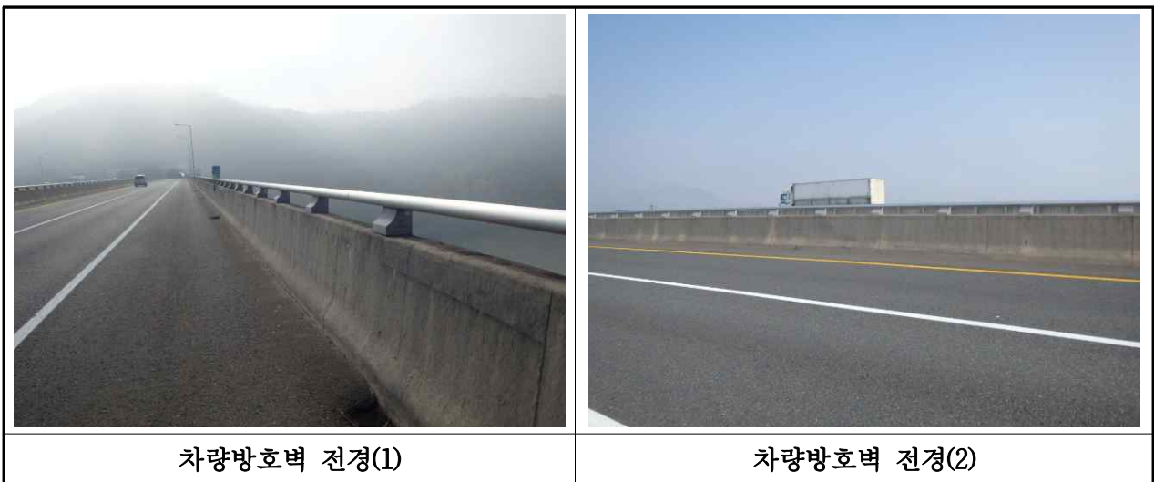
【사진 3.3.23】 난간 및 연석 전경(부산)
