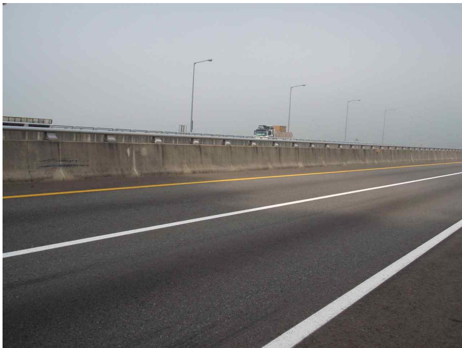
차량방호벽 전경 (2차로측)
